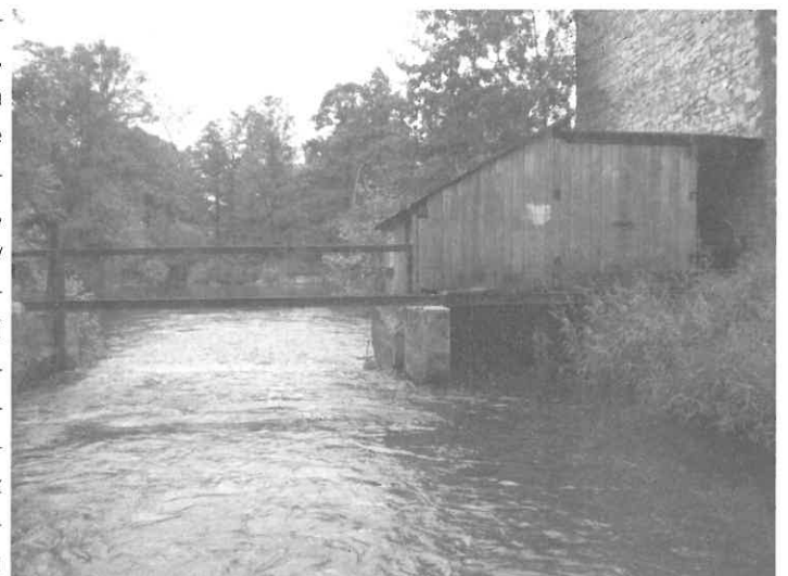
Fot.1 MEW w Bieleckich Młynach – widok od strony wlotu do istniejącego bloku turbinowni.
